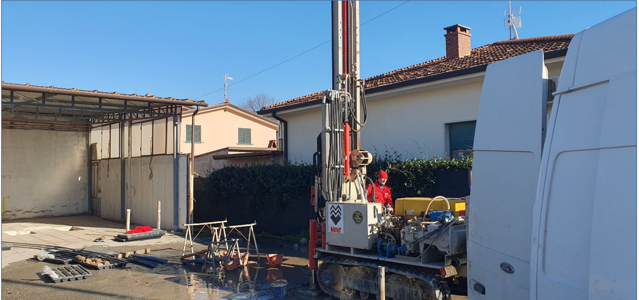
Figura 1: Sondaggio S1 - Postazione
