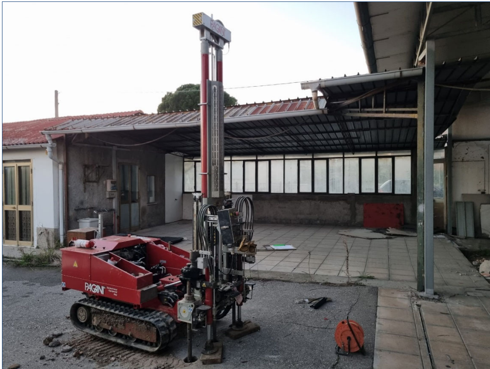
Figura 1: Postazione prova penetrometrica CPT 1
