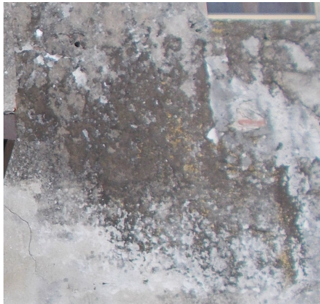
F - esempio di incrostazione in facciata
