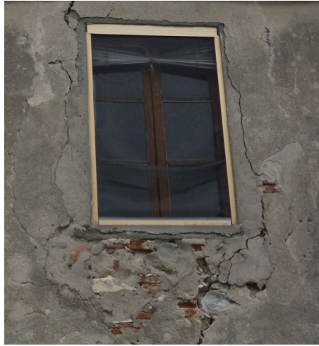
M - esempio di fessurazione in facciata
