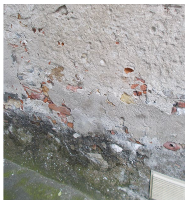
B - esempio di disgregazione in facciata
