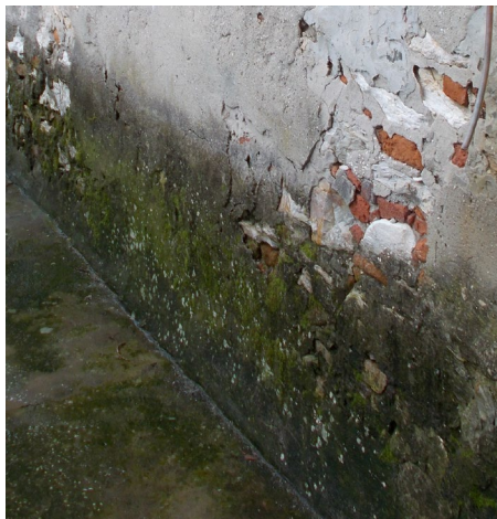
L - esempio di deposito superficiale in facciata
