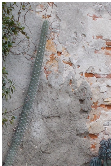
D - esempio di erosione in facciata
