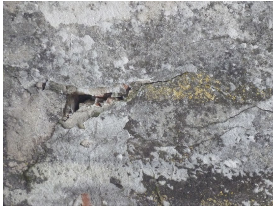
C - esempio di distacco in facciata
