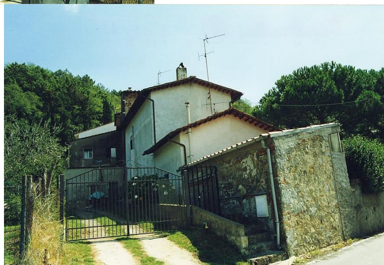
documentazione fotografica al settembre 1999
