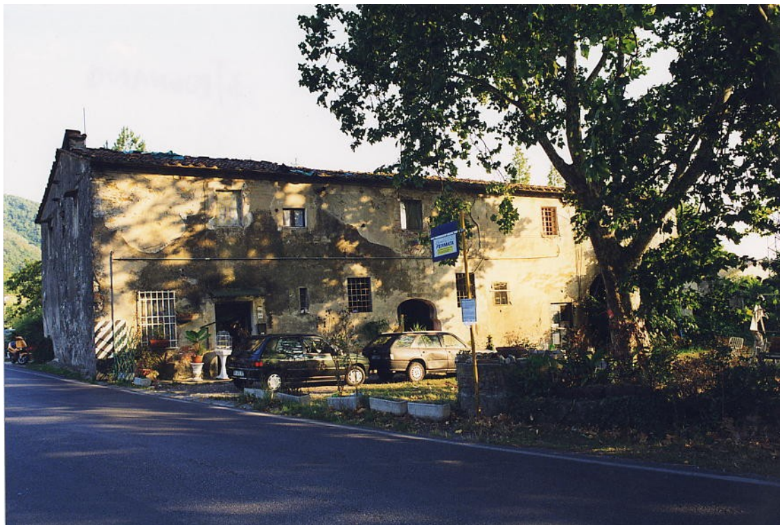
documentazione fotografica al settembre 1999
