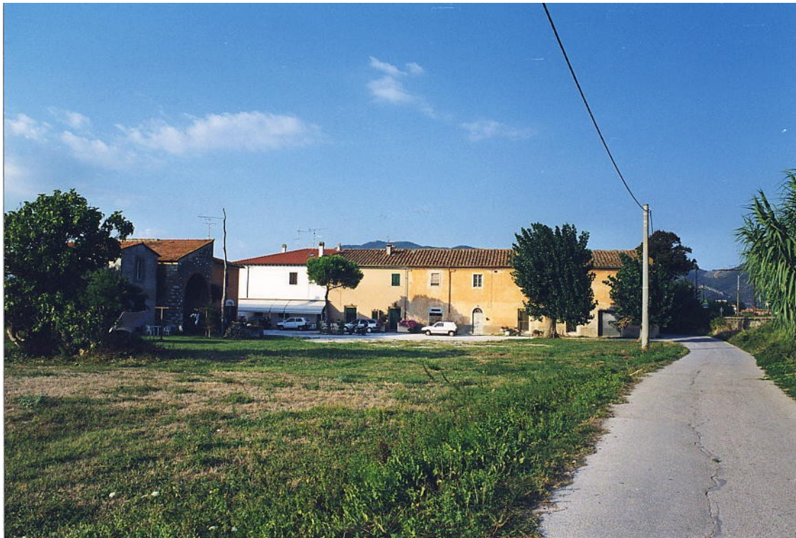
documentazione fotografica al settembre 1999
