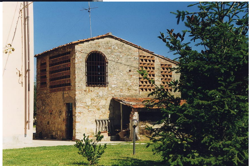
documentazione fotografica al settembre 1999
