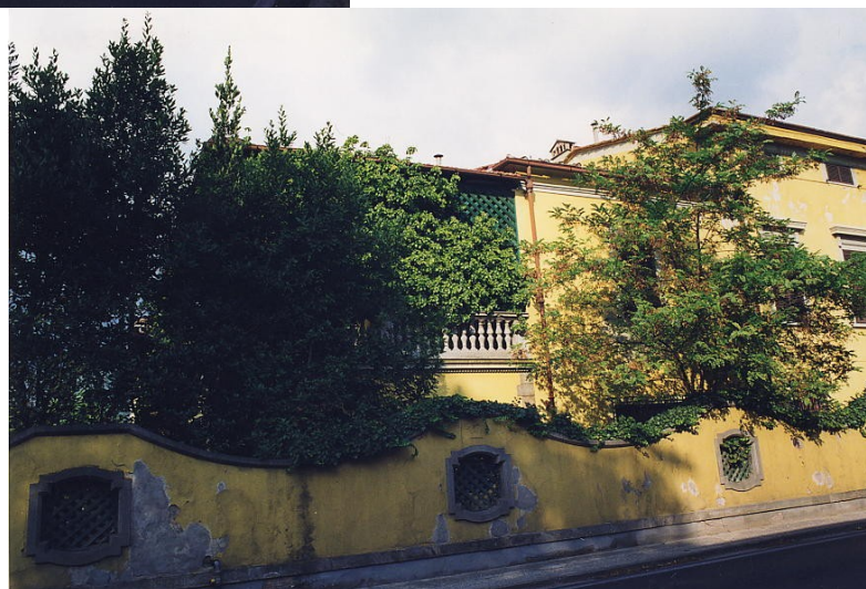
documentazione fotografica al settembre 1999
