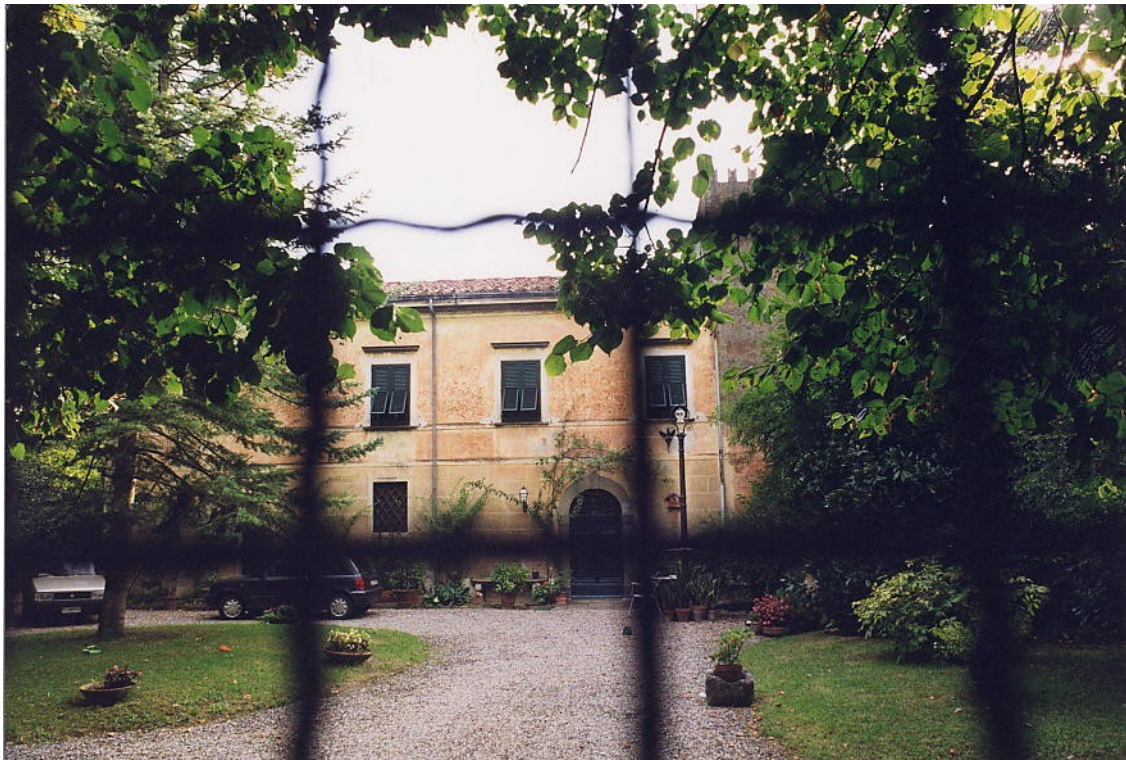
documentazione fotografica al settembre 1999
