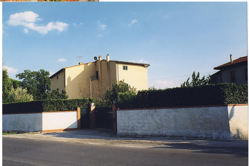
documentazione fotografica al settembre 1999
