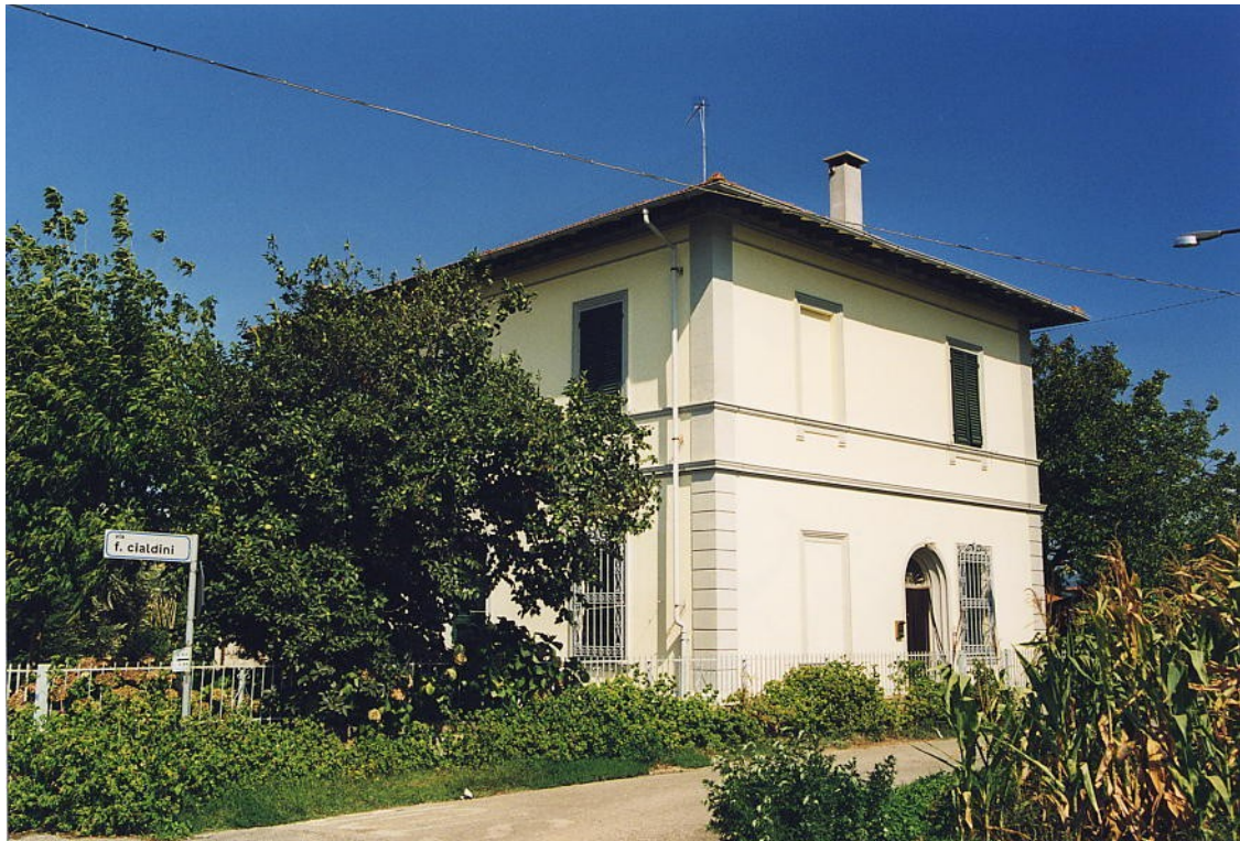
documentazione fotografica al settembre 1999
