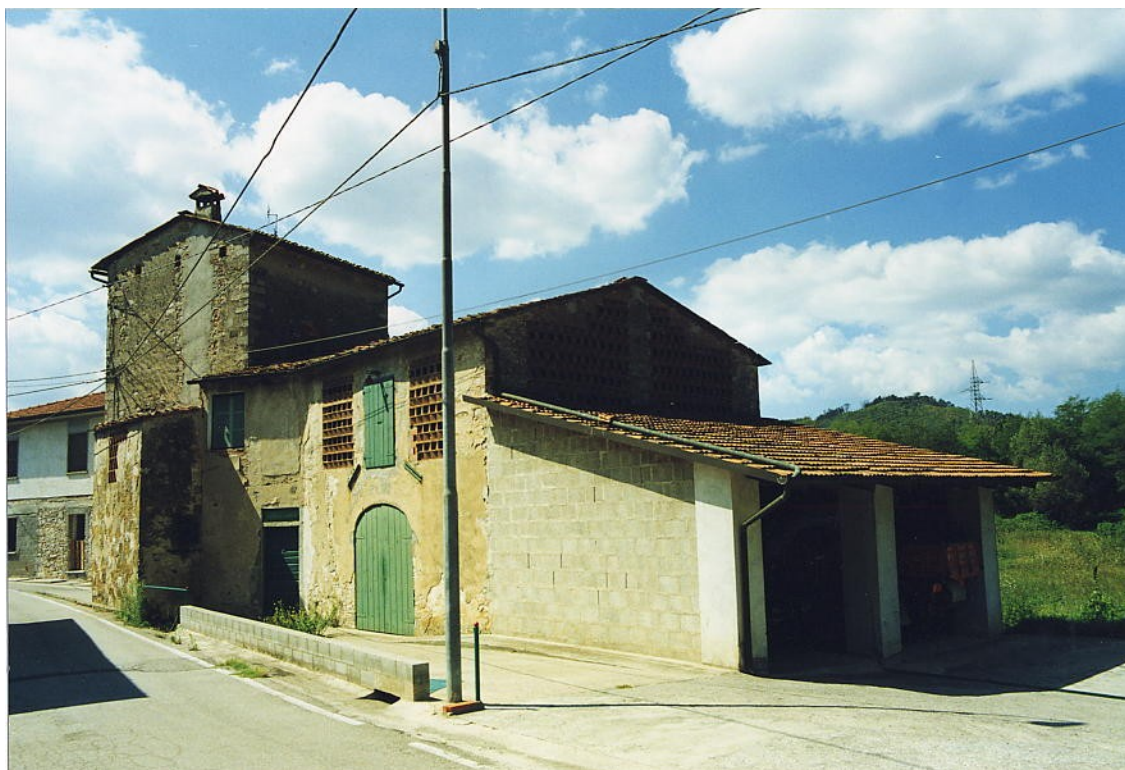
documentazione fotografica al settembre 1999
