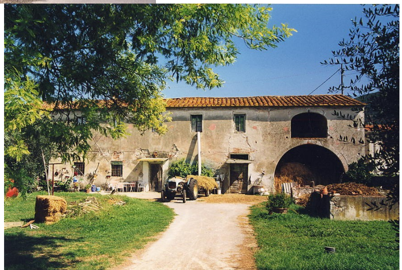
documentazione fotografica al settembre 1999
