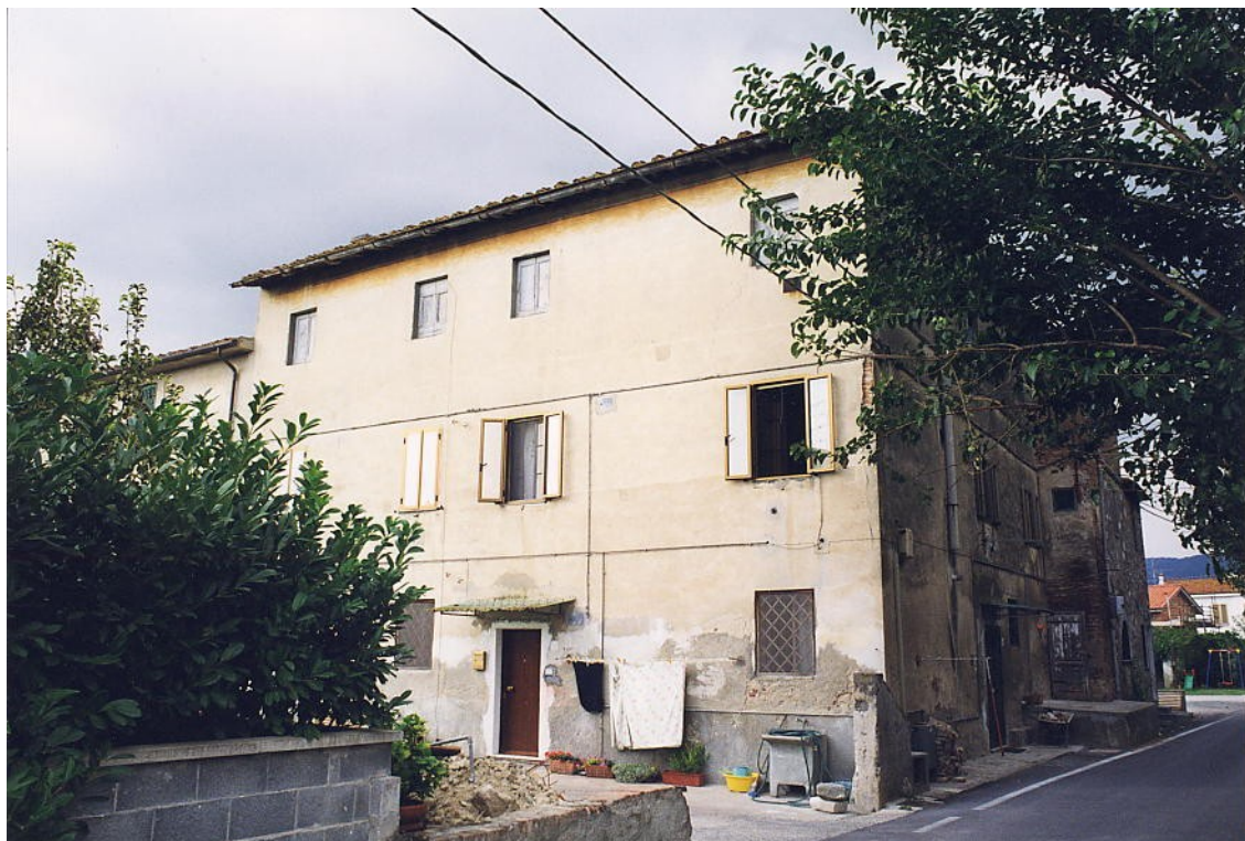
documentazione fotografica al settembre 1999
