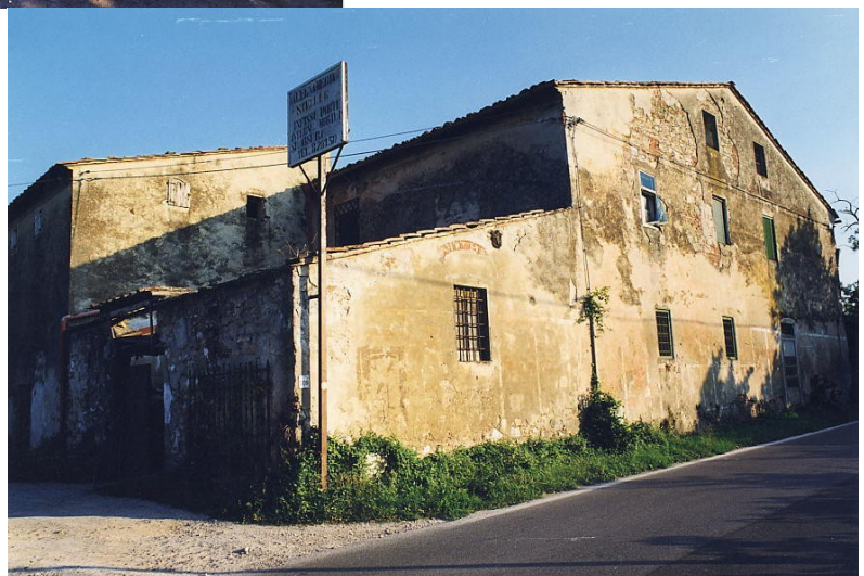
documentazione fotografica al settembre 1999
