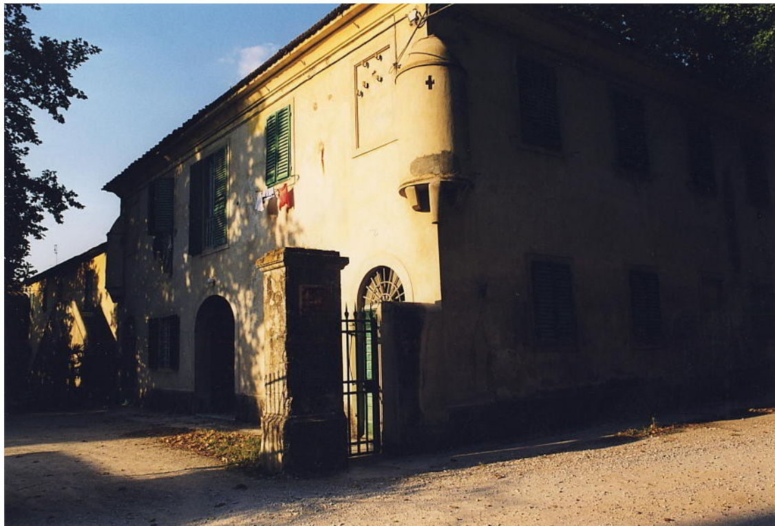
documentazione fotografica al settembre 1999
