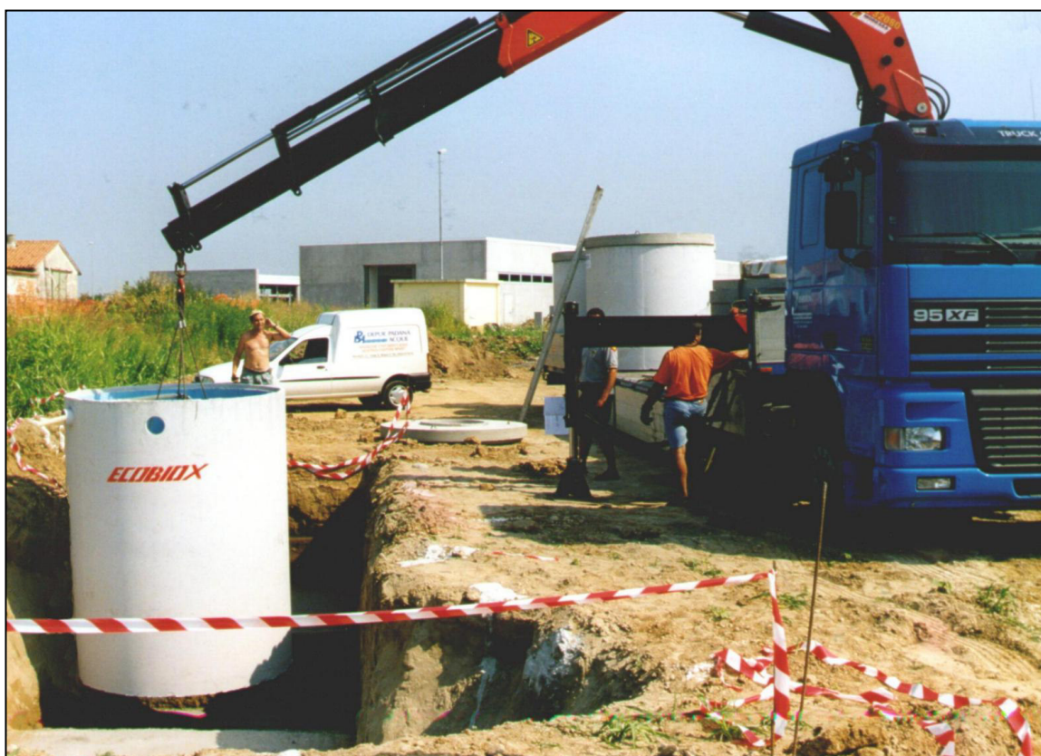
Fig. 3 – Fasi di interramento impianto Mod. ECOBIOX ® 2 – Serie C
