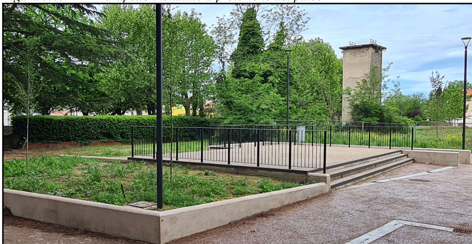
Figura 5.4c Parapetto installato a protezione del palco
