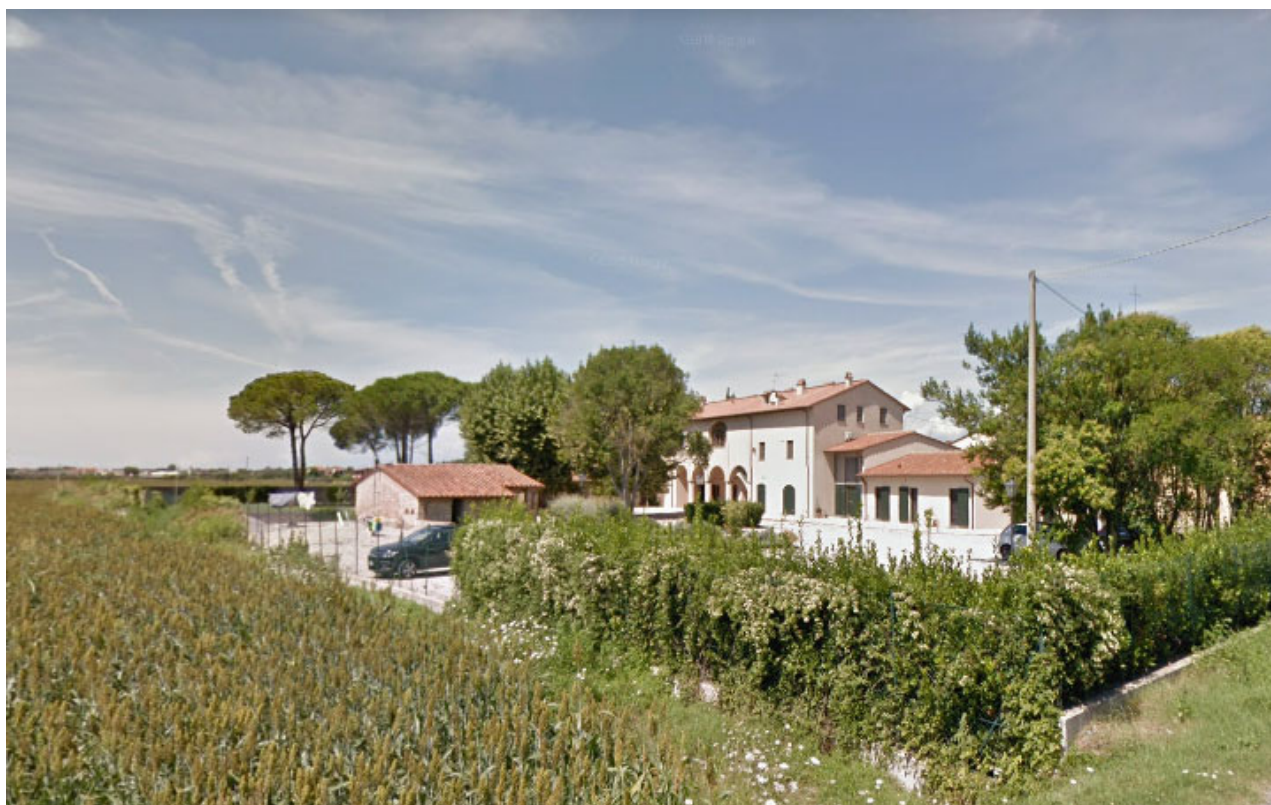
Figura 29 – Casa già Rucellai, Località Ghezzano, San Giuliano Terme (PI)
