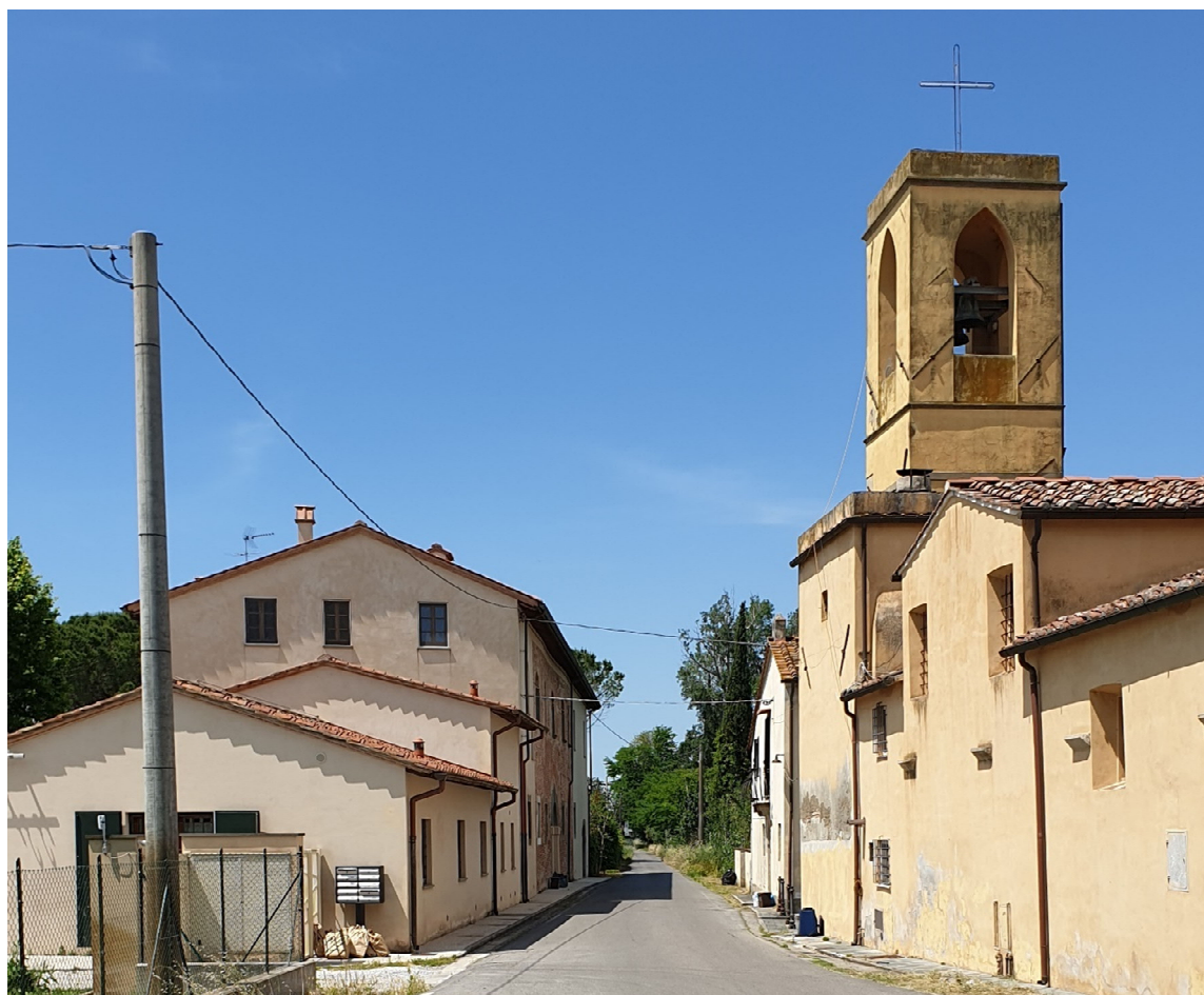
Figura 55 – Manufatti di valore storico culturale nel tratto tra i nodi 10 e 12 (Casa già Rucellai e Chiesa di Ghezzano)
