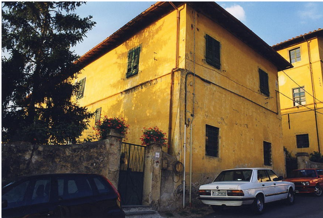
documentazione fotografica al settembre 1999
