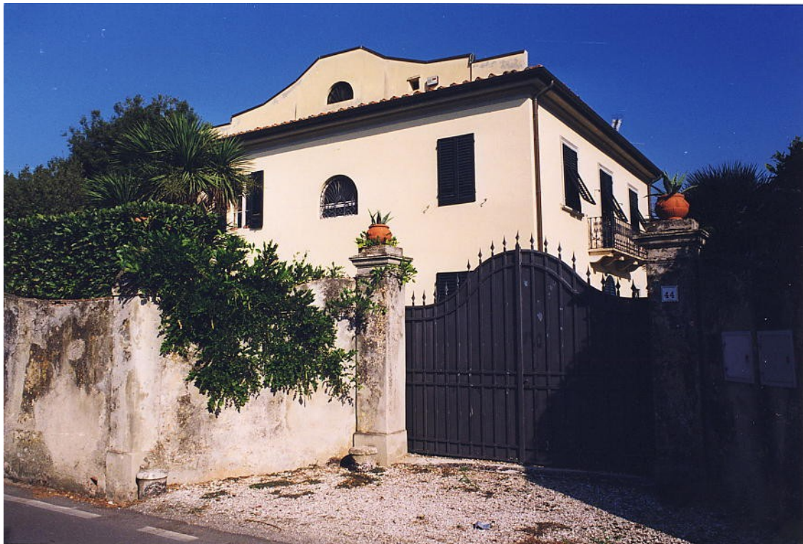
documentazione fotografica al settembre 1999
