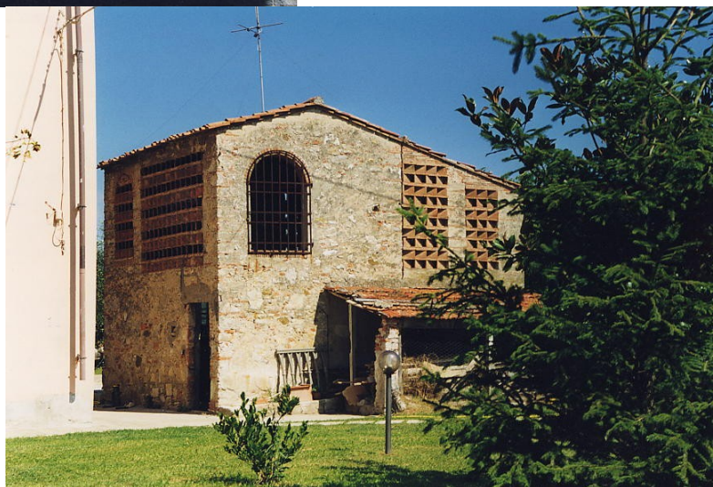
documentazione fotografica al settembre 1999
