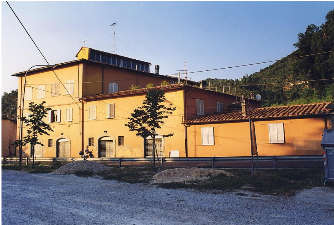
documentazione fotografica al settembre 1999
