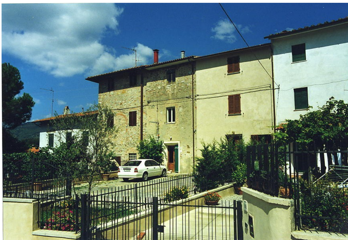
documentazione fotografica al settembre 1999
