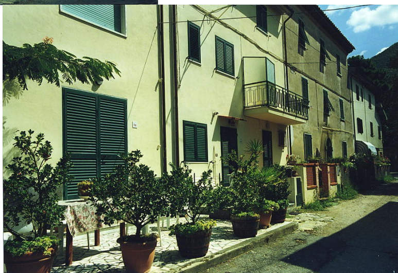
documentazione fotografica al settembre 1999
