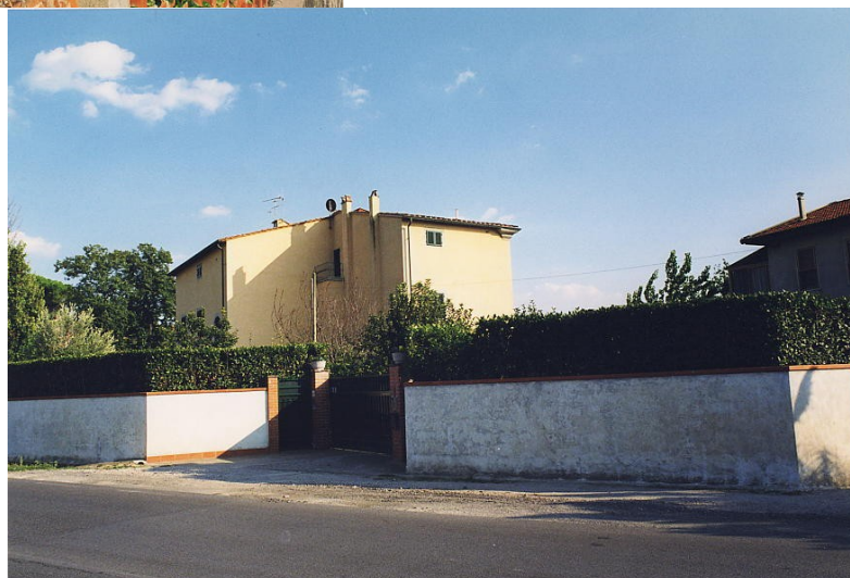
documentazione fotografica al settembre 1999
