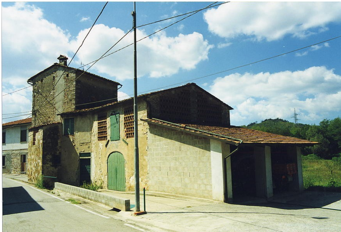
documentazione fotografica al settembre 1999
