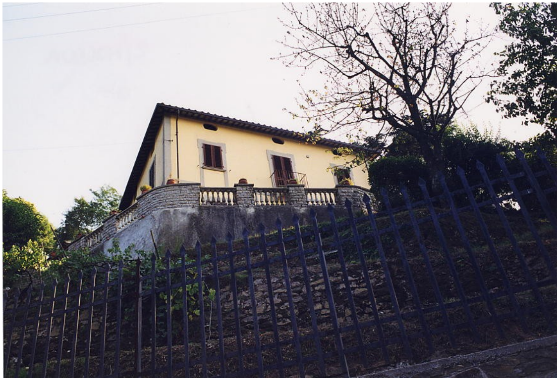
documentazione fotografica al settembre 1999
