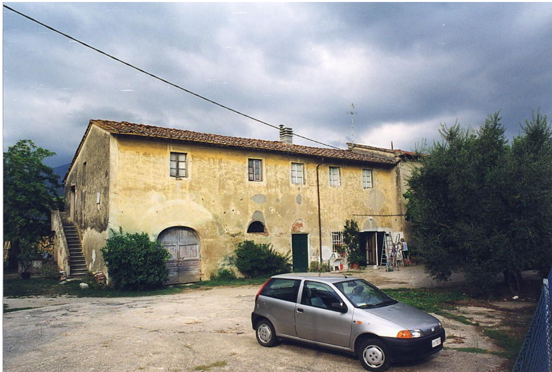
documentazione fotografica al settembre 1999
