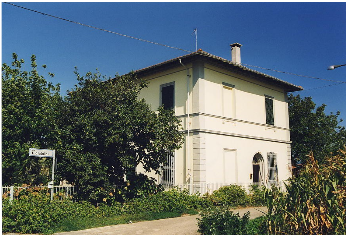
documentazione fotografica al settembre 1999
