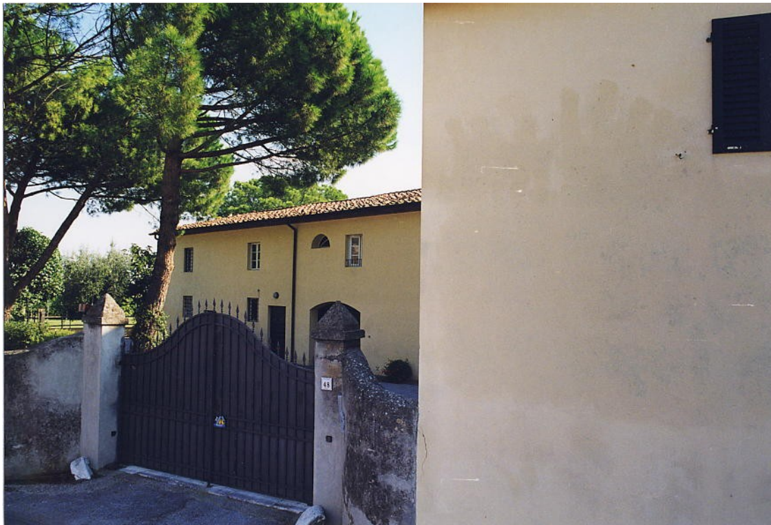
documentazione fotografica al settembre 1999
