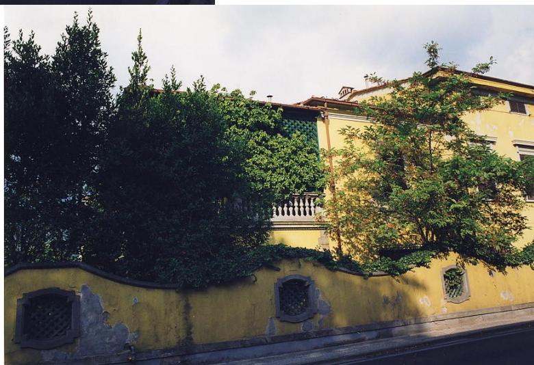
documentazione fotografica al settembre 1999
