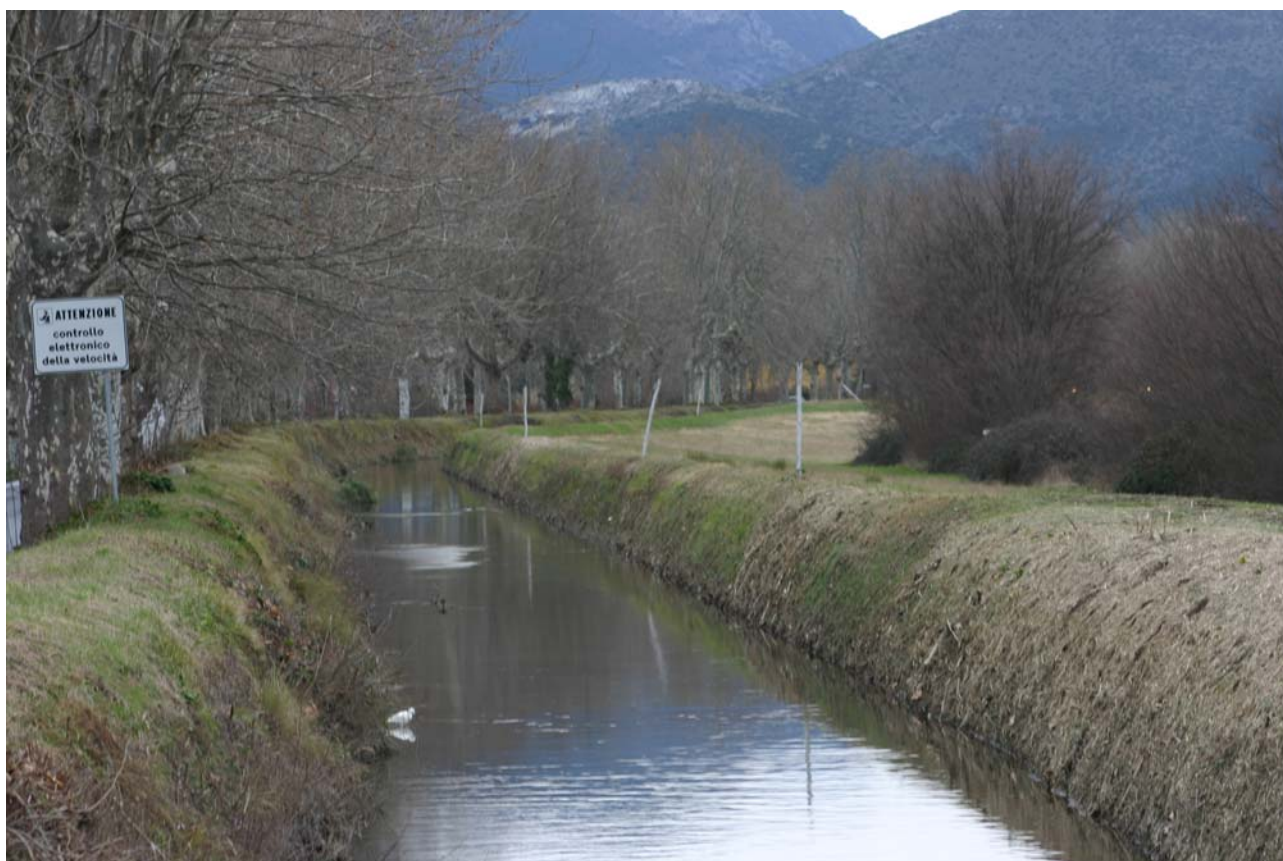
Il canale demaniale (Fosso dei Molini) e la parallela via del Brennero
