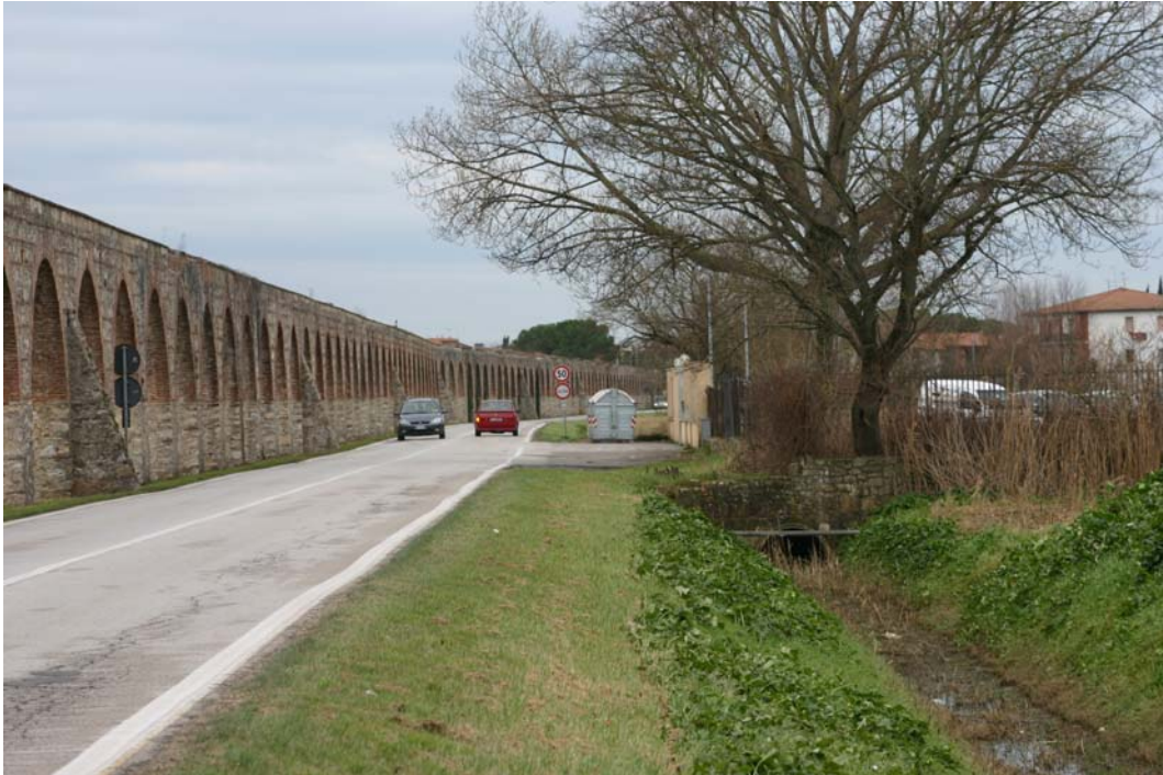
Via dei Condotti all'altezza del sottopasso
